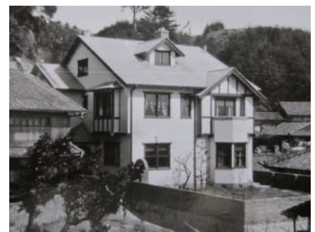
写真Ⅰ 竣工のころのチャップマン邸
